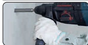
③ 打込み (専用マシンホルダー使用)
